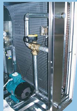
BRT tvåradars vattenbatteri med 3-vägsventil
