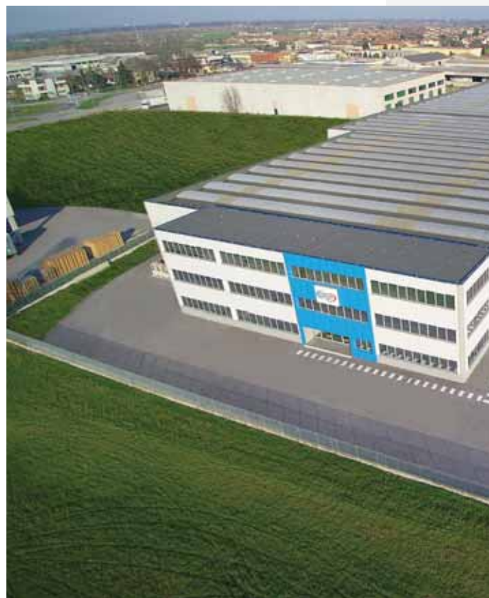
Argo - huvudkontoret i Alfianello, logistikcenter och projektledningskontor
